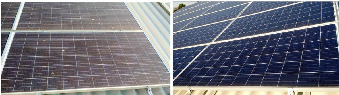
**Figura 58 – a) Sujidade sobre os painéis b) Situação dos painéis após lavagem pela chuva**
