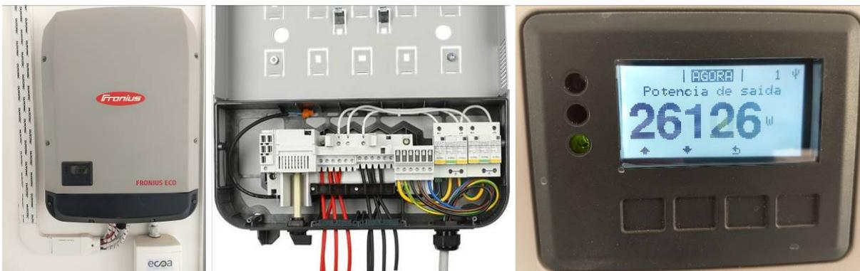
**Figura 43 – a) Inversor, b) Entradas e Saída do Inversor, c) IHM do Inversor**
