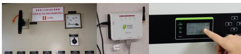
**Figura 37 – a) Distribuidor Geral, b) *Data Logger* e c) Parâmetros do Inversor**
