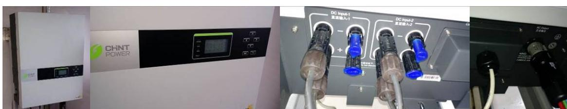
**Figura 36 – a) Inversor, b) IHM do Inversor, c) Entradas do Inversor e d) Saída do Inversor**
