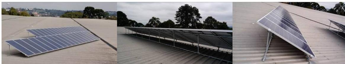
**Figura 35 – a) Arranjo físico dos Painéis do SFVCR, b) Estrutura de Fixação e c) Espaçamento entre os painéis**
