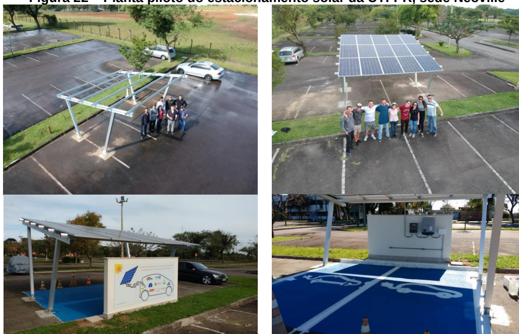
Figura 22 – Planta piloto do estacionamento solar da UTFPR, sede Neville
