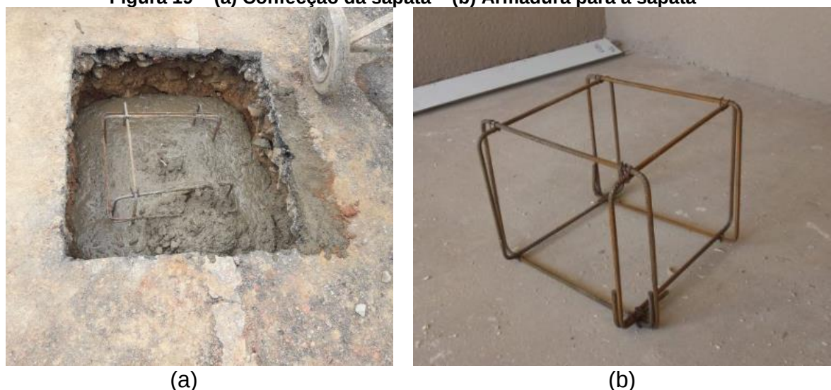
Figura 19 – (a) Confeção da sapata – (b) Armadura para a sapata
