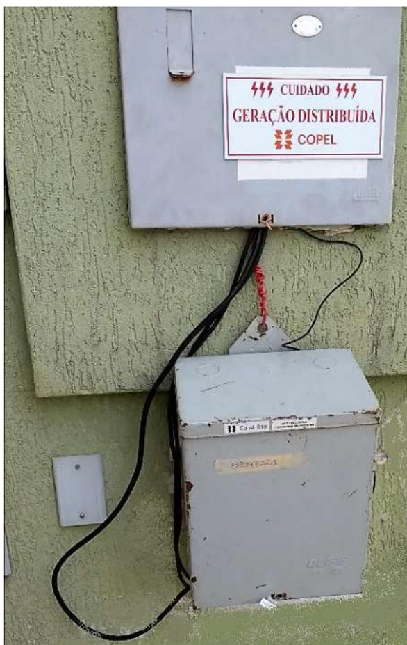
**Figura 47: Medidor Bidirecional em Paralelo.
