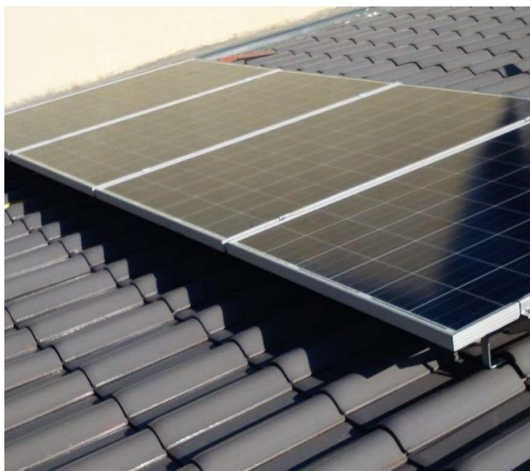
**Figura 35: Instalação dos 4 Primeiros Módulos**
