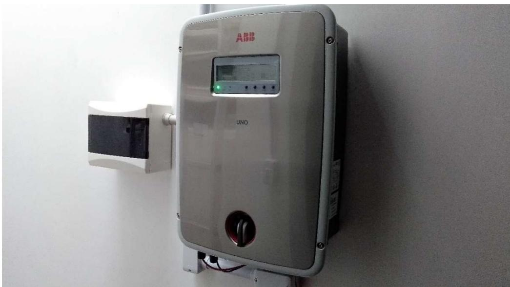
**Figura 43: Instalação Final do Inversor**
