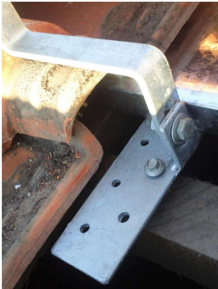
**Figura 31: Suporte Metálico de Fixação dos Módulos**
