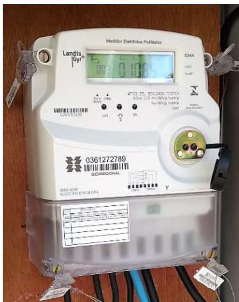
**Figura 44: Medidor Bidirecional**
