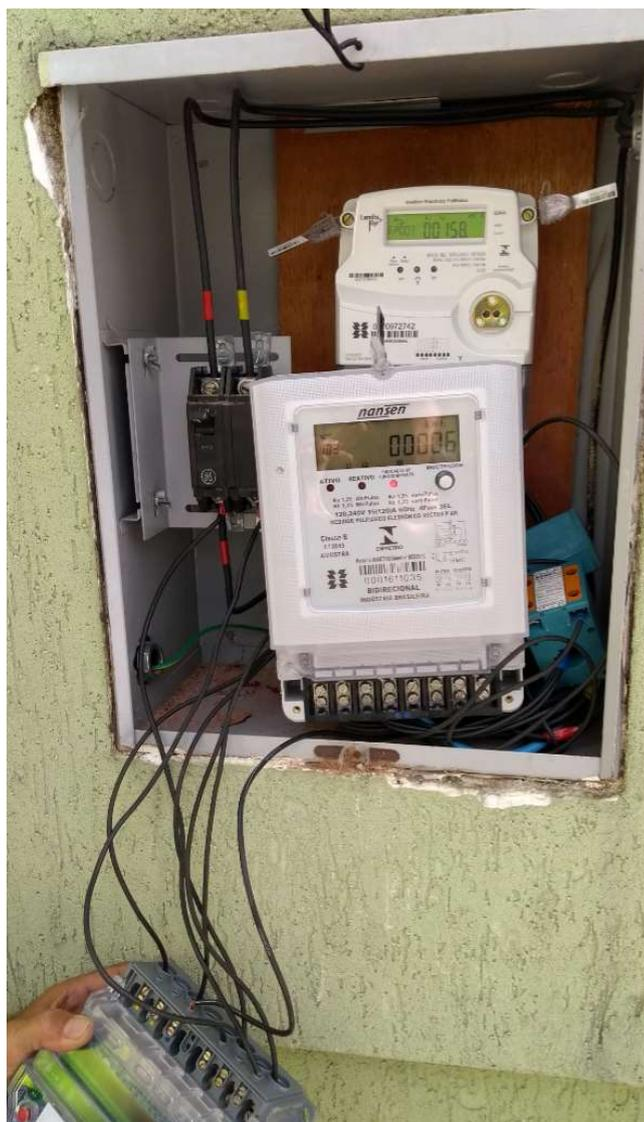
**Figura 48: Medidores em paralelo com o medidor da residência A.**
