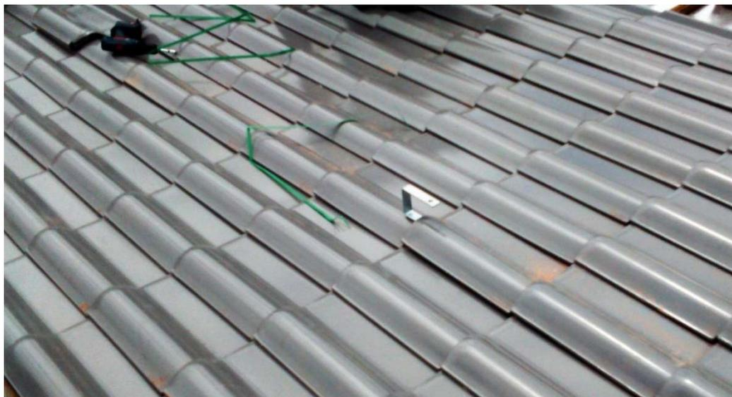
**Figura 32: Início da Fixação da Estrutura Metálica**
