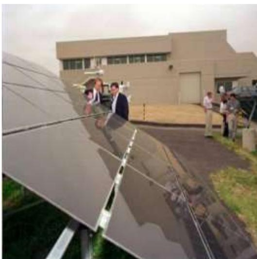
**Figura 7: Células de CdTe**
