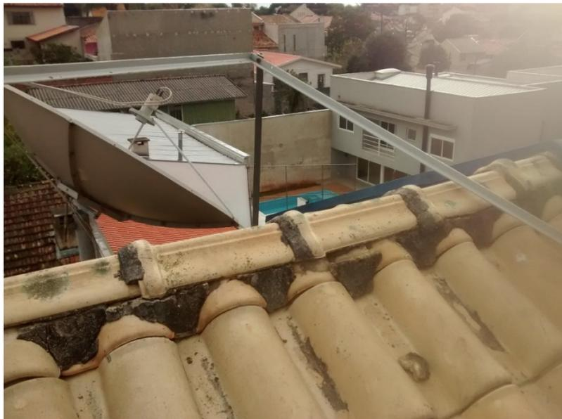
**Figura 19: Detalhe da instalação no telhado – fixação da estrutura nos pés**
