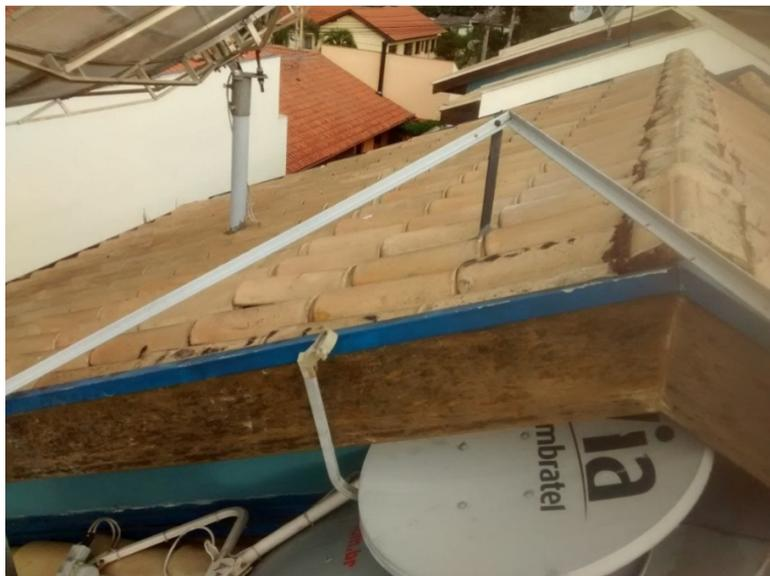
**Figura 20: Detalhe da instalação no telhado – evitando apoio sobre o telhado**
