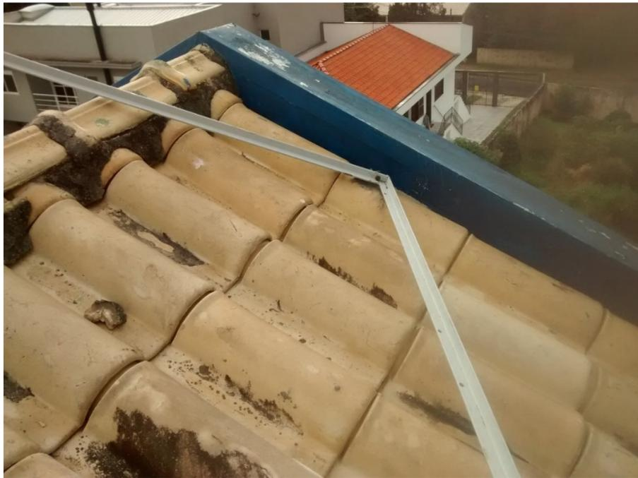
**Figura 18: Detalhe da instalação no telhado – furação das telhas para passagem dos pés**
