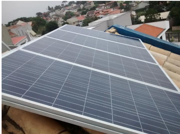
**Figura 22: Detalhe da instalação no telhado – fixação dos módulos na estrutura**
