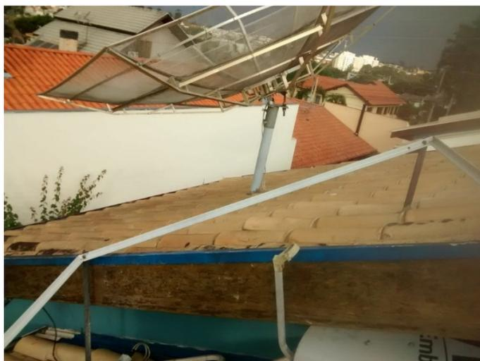
**Figura 21: Detalhe da instalação no telhado – fugindo das sombras**
