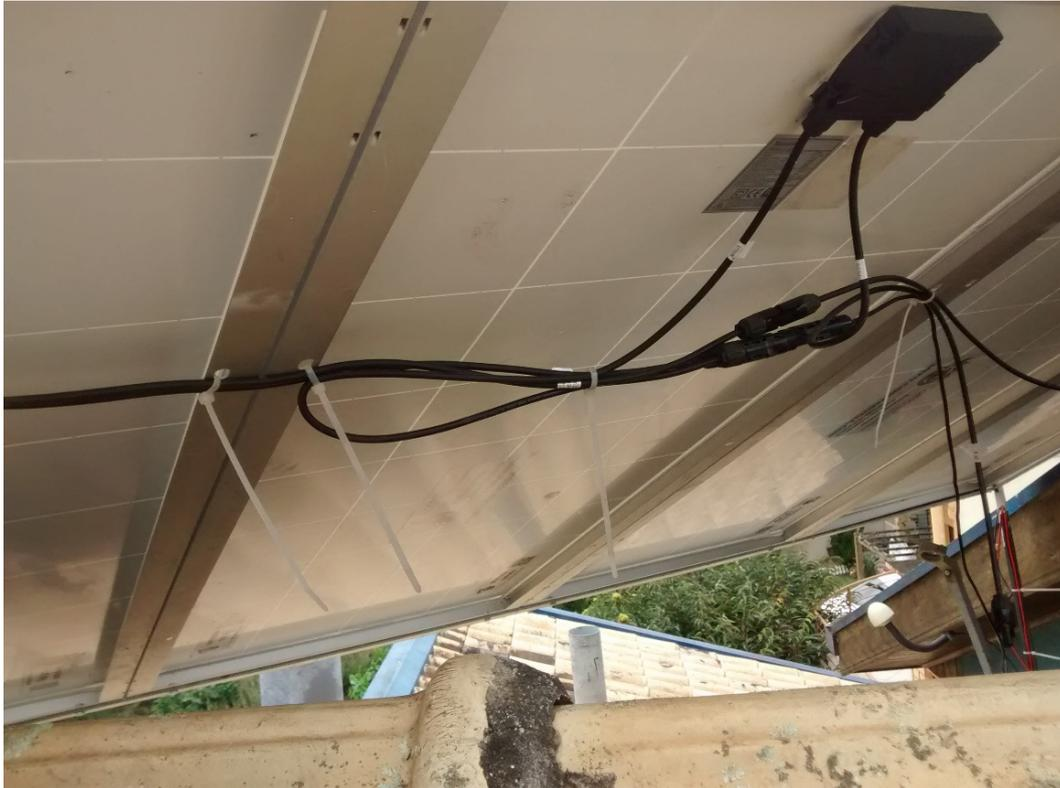
**Figura 25: Detalhe da instalação no telhado – fixação da fiação**
