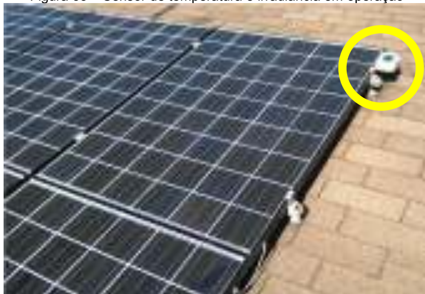
Figura 33 – Sensor de temperatura e irradiância em operação
