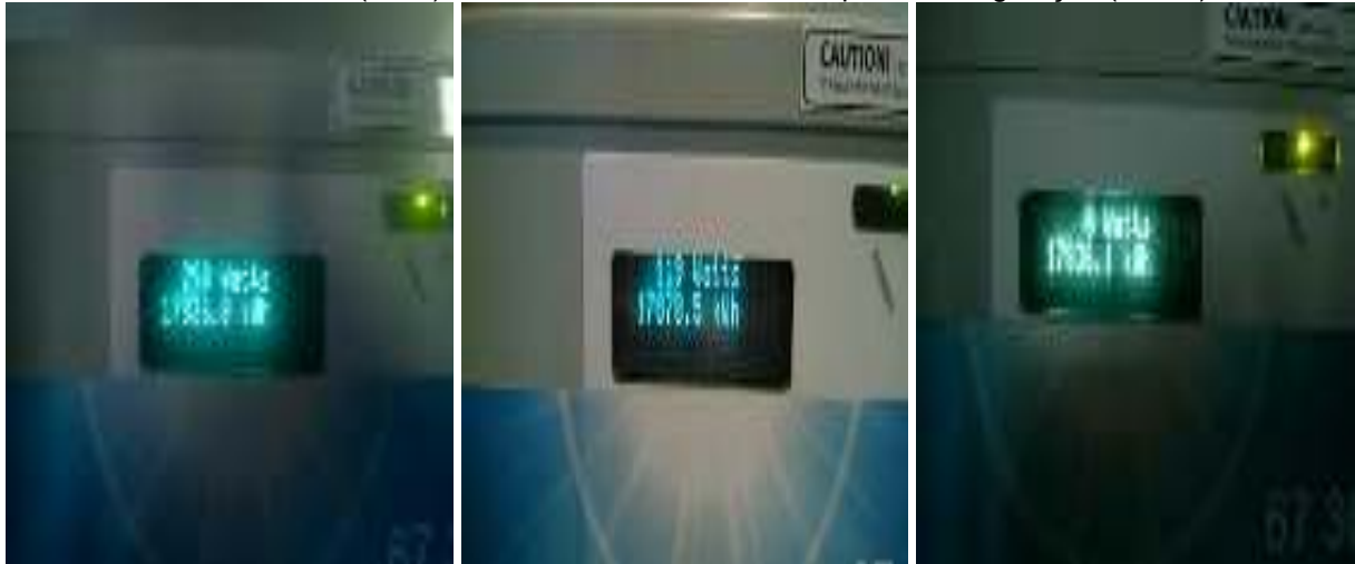
Figura 53 – Tela do inversor antes do sombreamento (esquerda) Tela do inversor durante o sombreamento (meio) e Tela no inversor no final do período de geração (direita)
