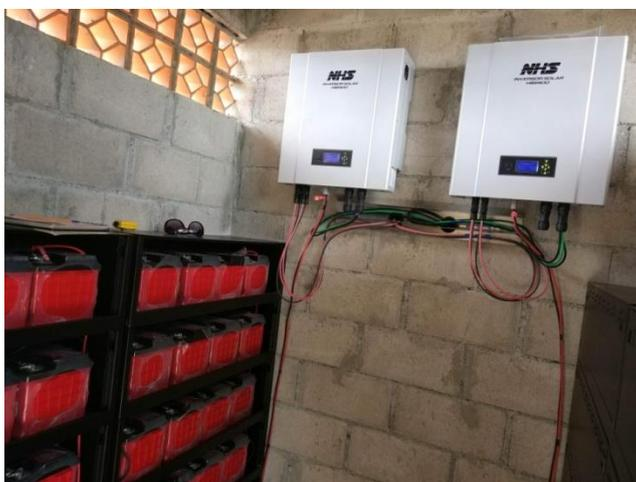
**Figura 7.** Inversores NHS 5kW e Baterias Heliar DF 1000 instalados no abrigo.
