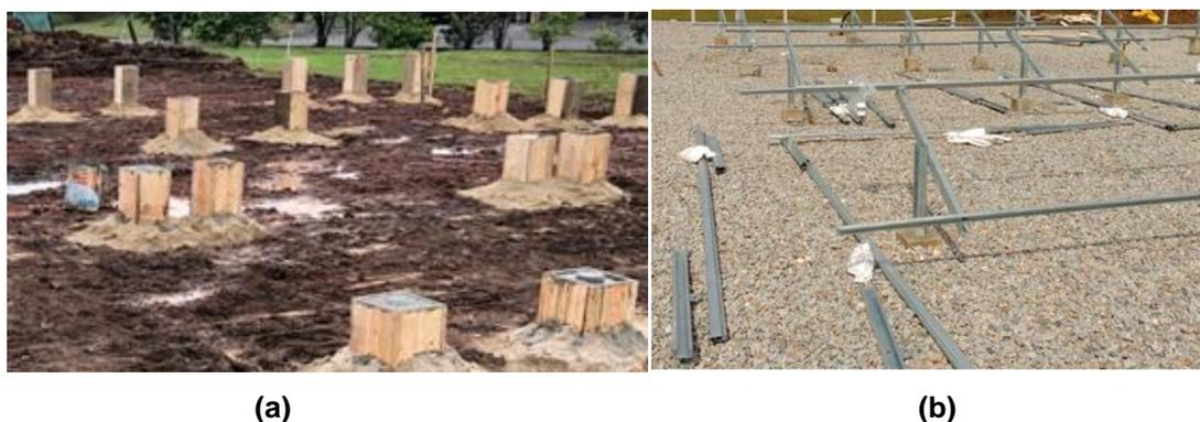
**Figura 4.** (a) Preparação das caixas para concretagem da fundação e (b) instalação dos suportes para as estruturas metálicas.
