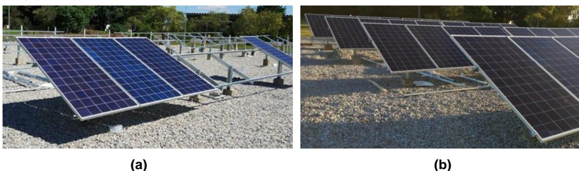
**Figura 5.** (a) Início da instalação dos módulos 335Wp; (b) Término da instalação dos módulos.
