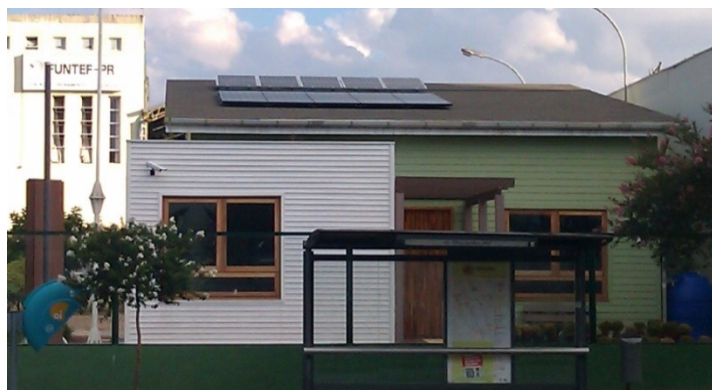
Figura 1 - Vista frontal do EV da UTFPR.
