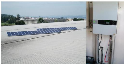
Figura 8. Vista dos módulos e do inversor (Acervo do autor)
